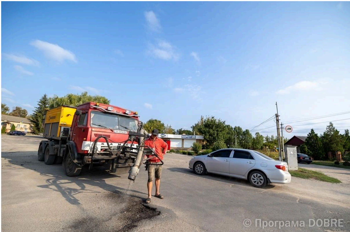
Ремонт доріг/ Джерело
